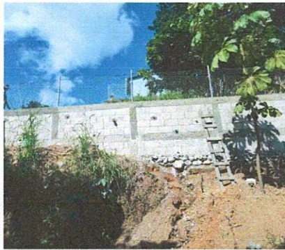
Foto 1: Mejoramiento de 38m 2 de muro de contencion para resguardar la integridad fisica de sniños y niñas de nuestro establecimiento.
