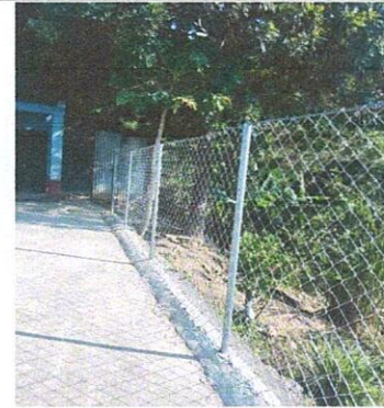
Foto 4: Mejoramiento 18.75m 2 de cerco perimetral colocando malla con tubo galvanizado para resguardar la integridad fisica de niños y niñas de nuestro establecimiento.
