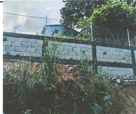
Foto 2: Mejoramiento de 38m 2 de muro de contencion para resguardar la integridad fisica de sniños y niñas de nuestro establecimiento.
