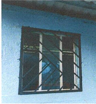
Foto1: Colocacion de balcones a las ventanas del modulo de la cocina siendo aspecto de seguridad para los enseres y resguardarlos.
